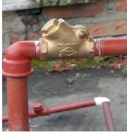
Figura 12: Válvula check del secador solar de maíz y maní.
