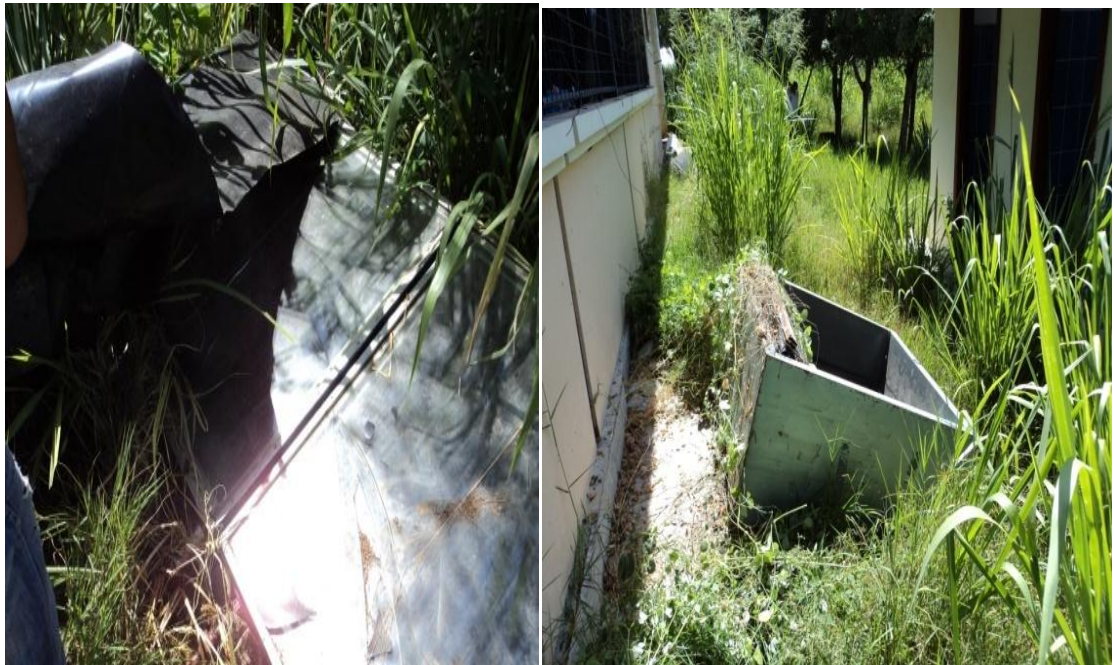
Figura 6: Situación actual de los colectores y del silo en el Centro Binacional de formación técnica de Zapotepamba.
