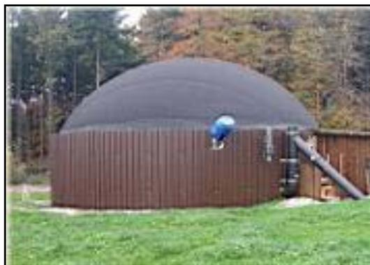
*Figura d.7 Digestor con tanque de almacenamiento tradicional y cúpula de polietileno.*
