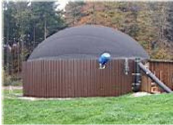
Digestor con tanque de almacenamiento tradicional y cúpula de polietileno.
