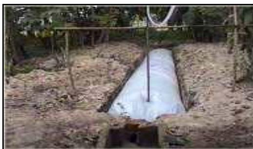
*Figura d.6. Biodigestor de estructura flexible.*
