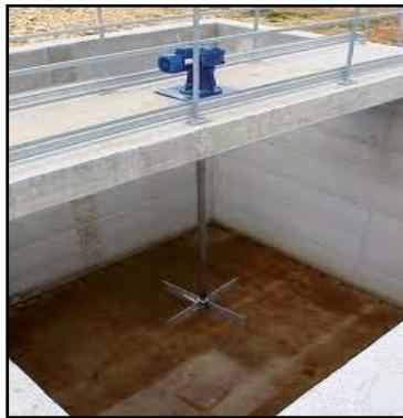
*Figura d.10. Agitador vertical.*
