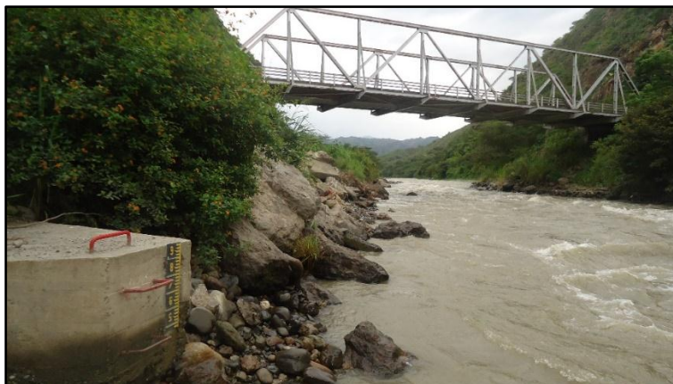
Foto 1. Vista de la estación limnimétrica ARENAL EN PTE. BOQUERON
