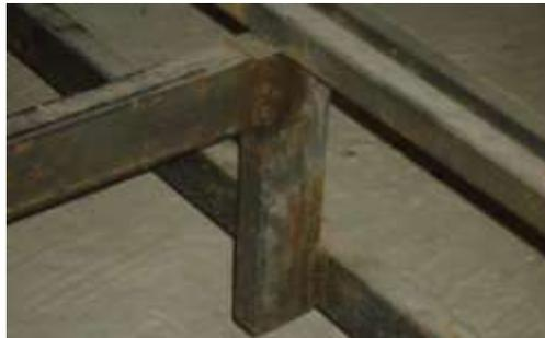
Figura 49: Apoyo de tubo rectangular para cremalleras
