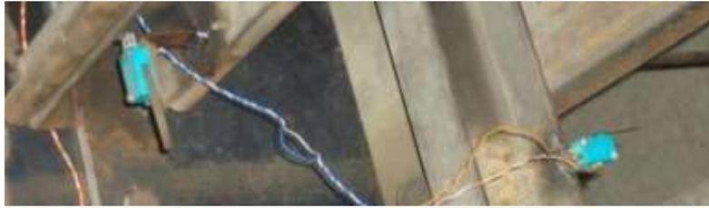
Figura 51: Soporte tipo L para los finales de carrera
