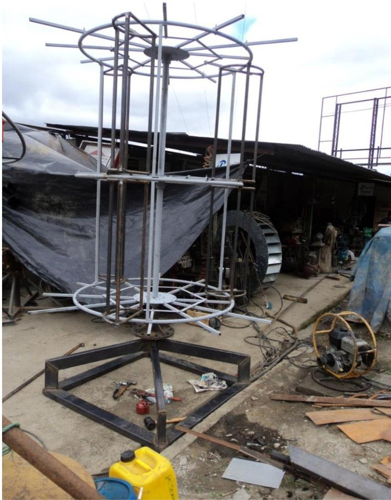
Estructura del Aerogenerador
