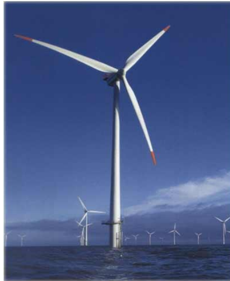
Figura 2. Aerogenerador con eje horizontal.
