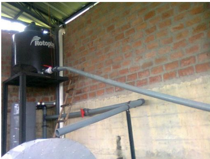
Fig. 30: Elementos del ariete de doble bombeo
