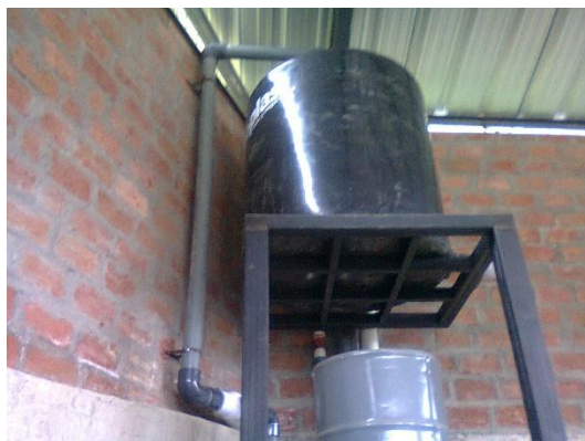
Fig. 9. Instalación del tanque de alimentación.
