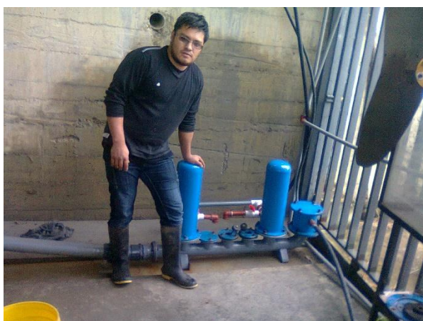
Fig. 10. Instalación del ariete de doble bombeo.
