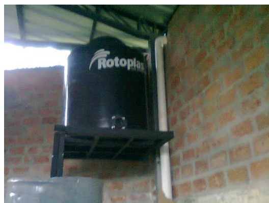
Fig. 9. Instalación del tanque de alimentación.
