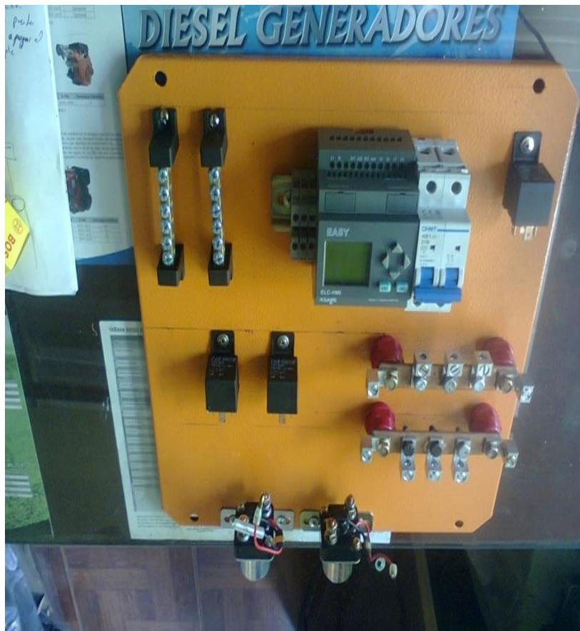
Figura 32. Elementos de control y de fuerza que conforman el sistema de arranque.
