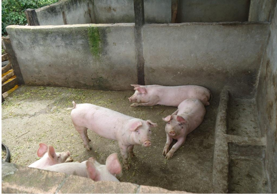
Figura 2.5. Divisiones de cemento y comederos al piso en Catamayo
