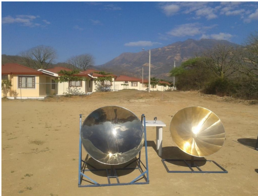
Gráfica 29 Instalación de la cocina para el monitoreo
