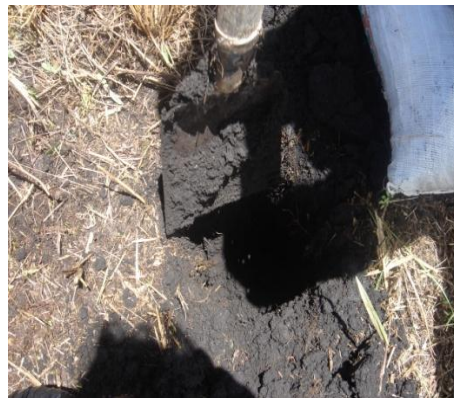
Extracción de chamba/capa 0, de la calicata.
