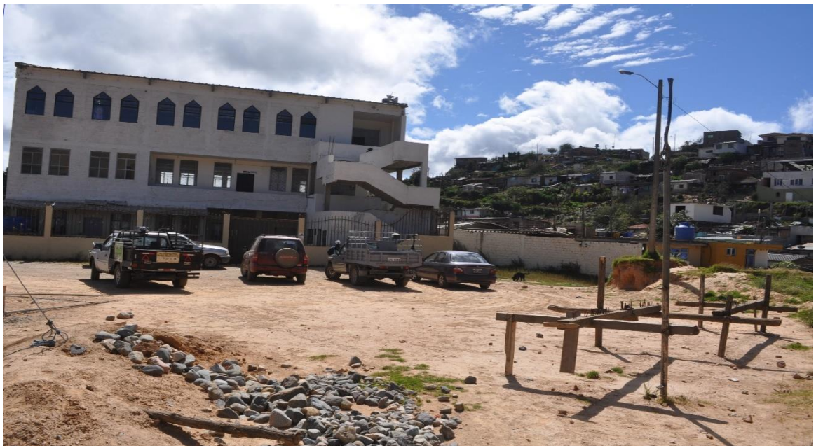
Fotografía 5: Capilla- Iglesia del Barrio Tierras Coloradas
