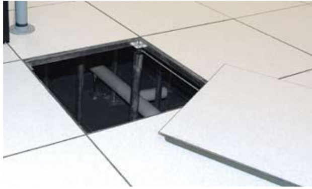
Figura 31. Piso Técnico de 60cm*60cm [23]
