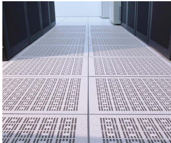
Figura 32. Piso Técnico Con Paneles Perforados 60*60 [23]
