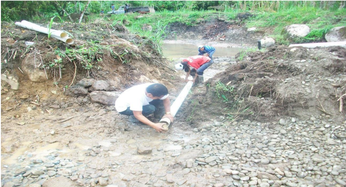
Figura 22. Construcción de estanque para engorde de tilapia. Barrio Nanguipa.
