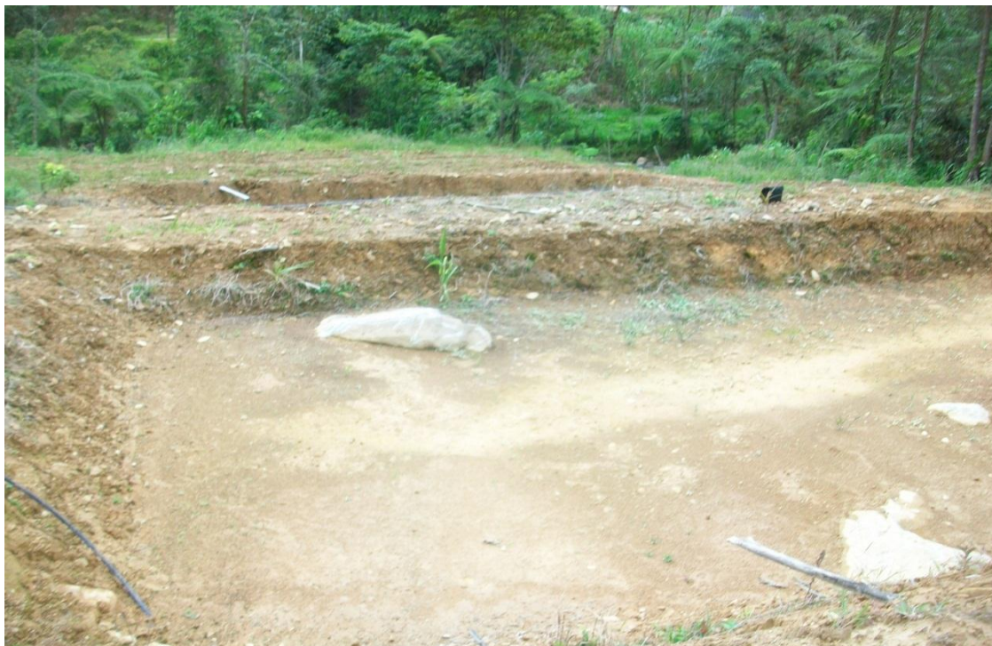
Figura 18. Construcción de estanques para engorde de tilapia. Parroquia Zumbi.
