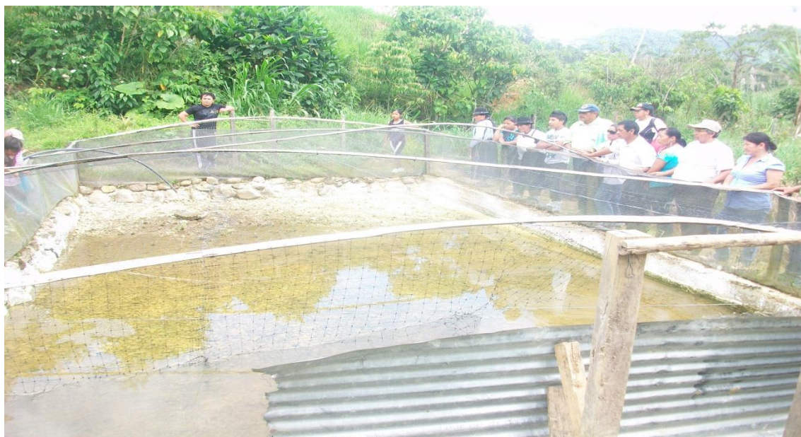
Figura 21. Construcción de estanque para engorde de tilapia. Sector Tuntiak. Crédito otorgado por el BNF.
