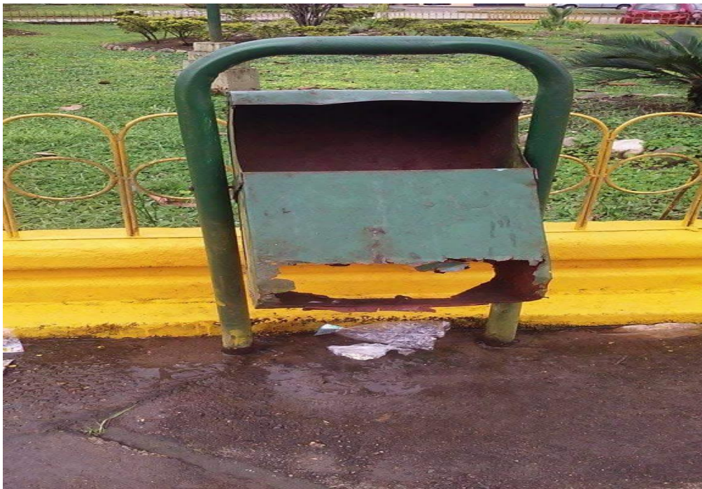
Contenedores de basura destruidos
