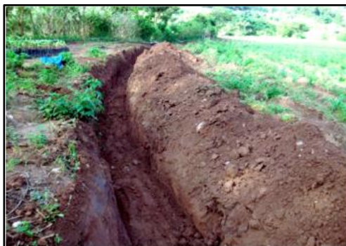
Fotografía No. 05: Drenaje del cultivo. Fuente: Autor
