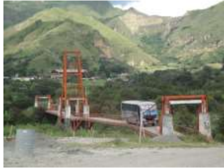
FOTO 4. Puente del río Piscobamba que une la parroquia Quinara con sus barrios Sahuaycu y la Palmira.
