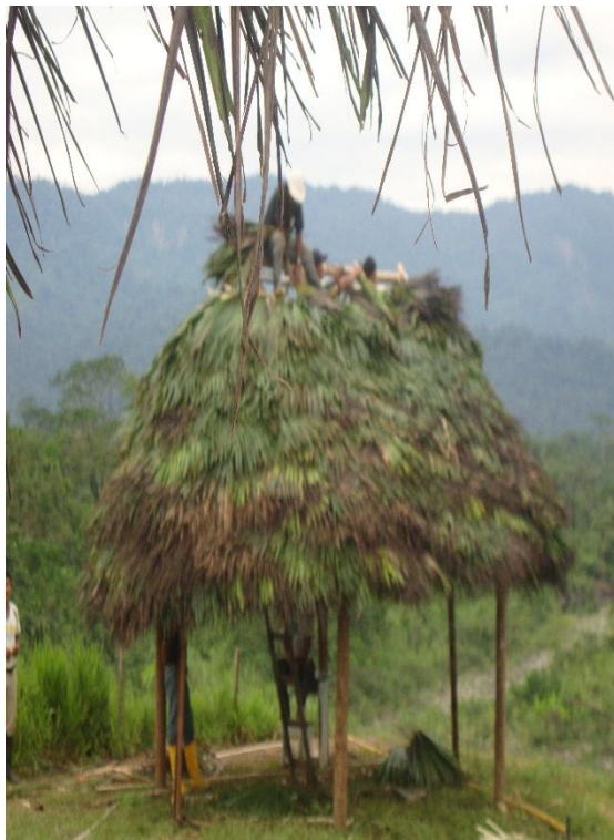
Fig. 14: Construcción de Casa Ceremonial
