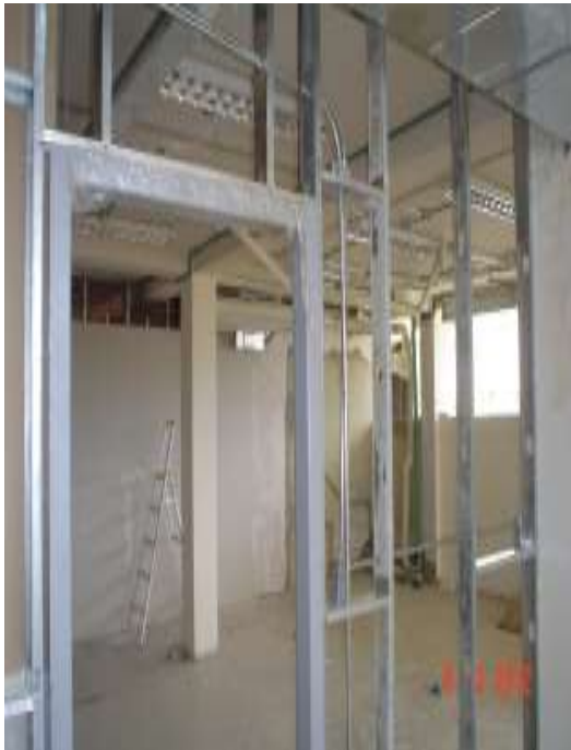
ARMADO DE ESTRUCTURA-PERFILES
