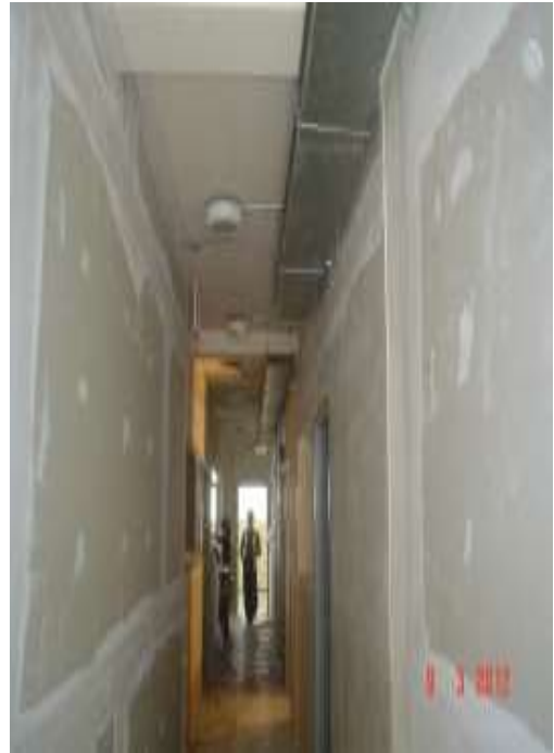
EMPOTRADO PLANCHAS FIBROCEMENTO
