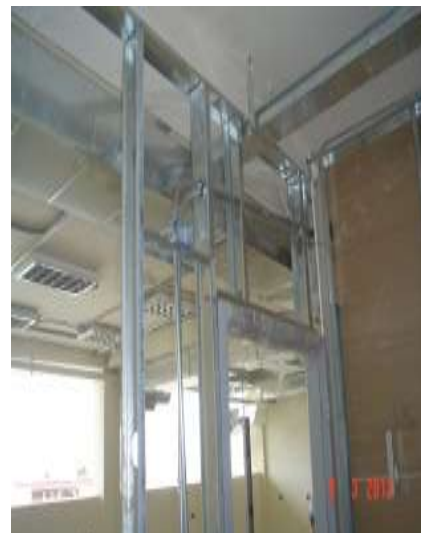
ARMADA DE ESTRUCTURA-PERFILES
