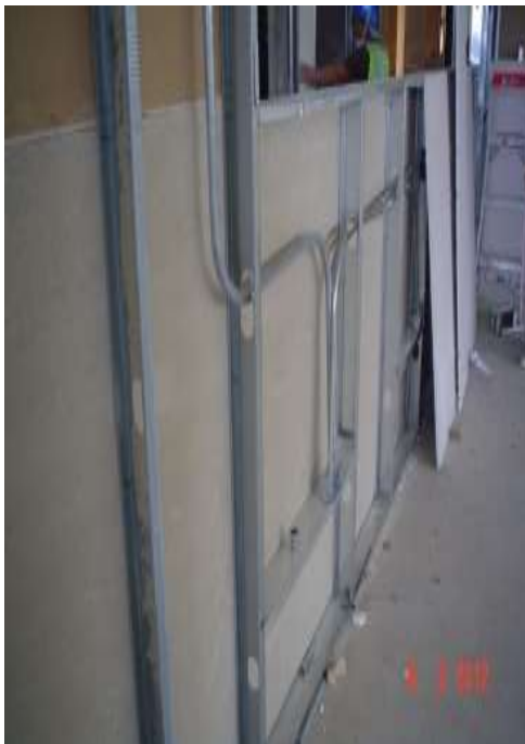
EMPASTADO DE UNIONES DE PLANCHAS
