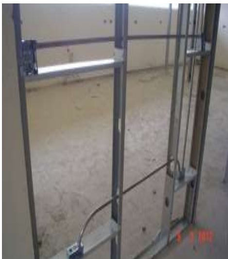
ENMANGUERADO PARA INSTALAC. ELECT.
