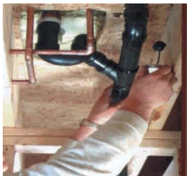
Verificación de instalaciones de gas
