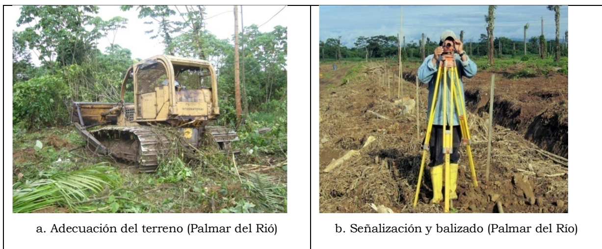
Figura 7. Preparación del terreno
