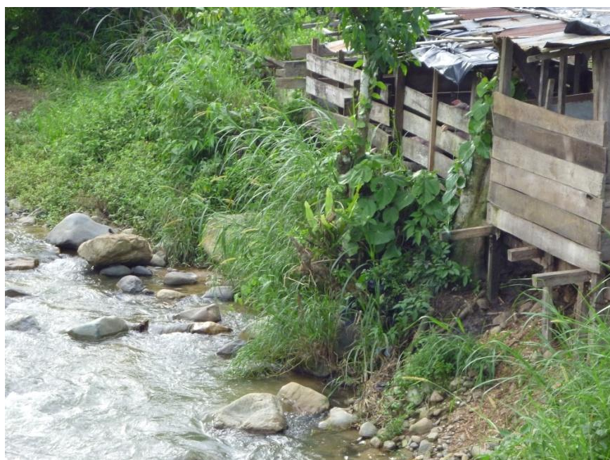
Figura 14. Sector El Mirador, construcción de chancheras en las orillas de la quebrada.
