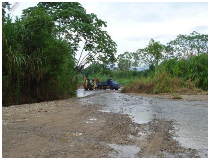
Figura 18. Extracción de material pétreo.
