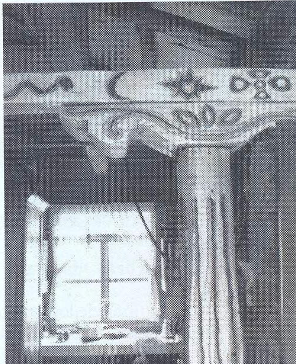
ACABADO DE PILAR CON MADERA RECICLADA
