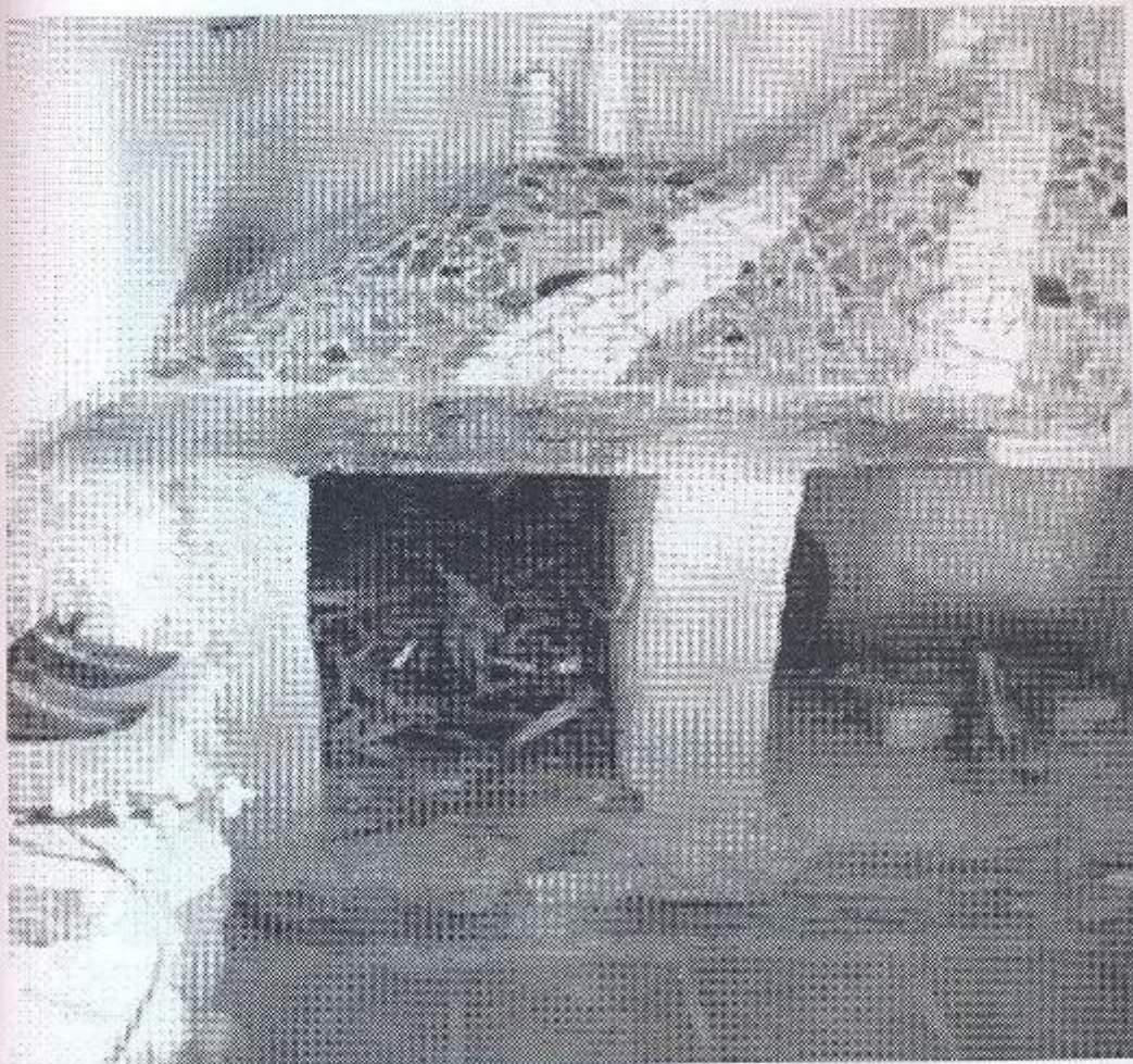
PROCESO DE ELABORACIÓN DE UNA CHIMENEA Y SU CONJUNTO-MOSAICO
