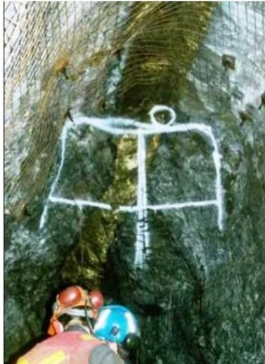
**Figura 2.** Muestreo de canaleta al techo.
