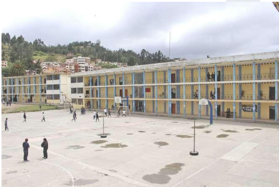
Figura 2. Infraestructura de Colegio de Bachillerato "Beatriz Cueva de Ayora"
