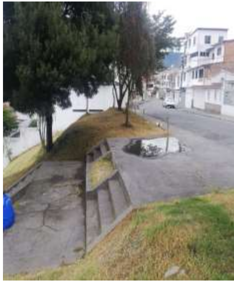
Formación de baches y agua empozada
