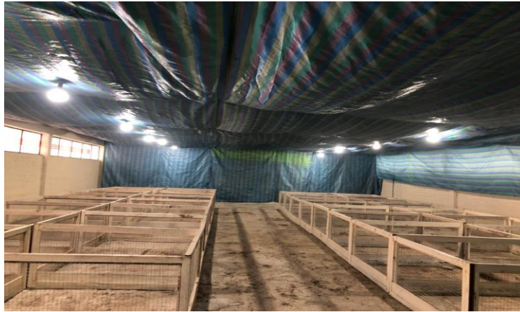
Figura 2. Adecuación de las instalaciones
