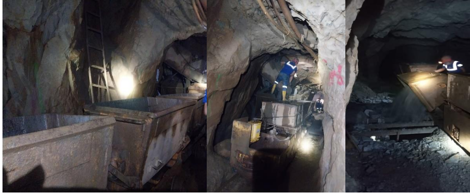
Figura 18. Tercera etapa del Sistema carga – acarreo.
