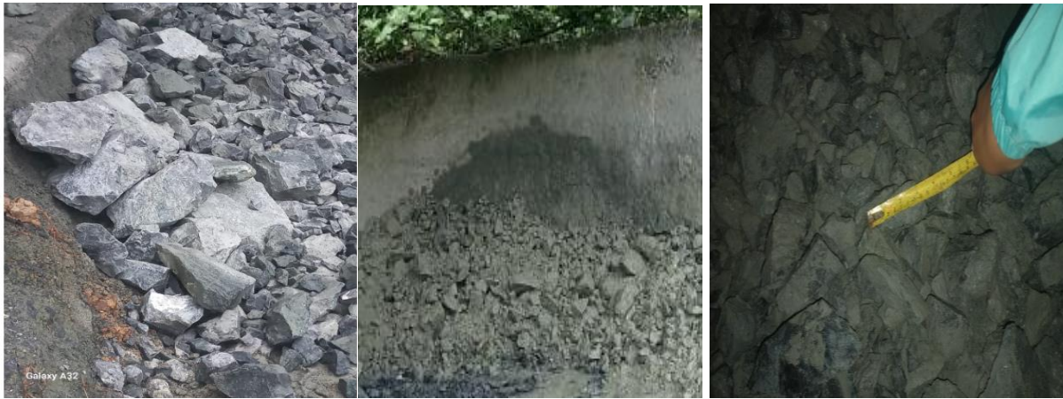
Figura 17: Dimensiones de los fragmentos resultado de la voladura actual.
