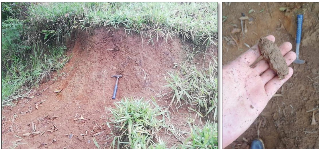
Figura 41: Afloramiento de suelo residual
