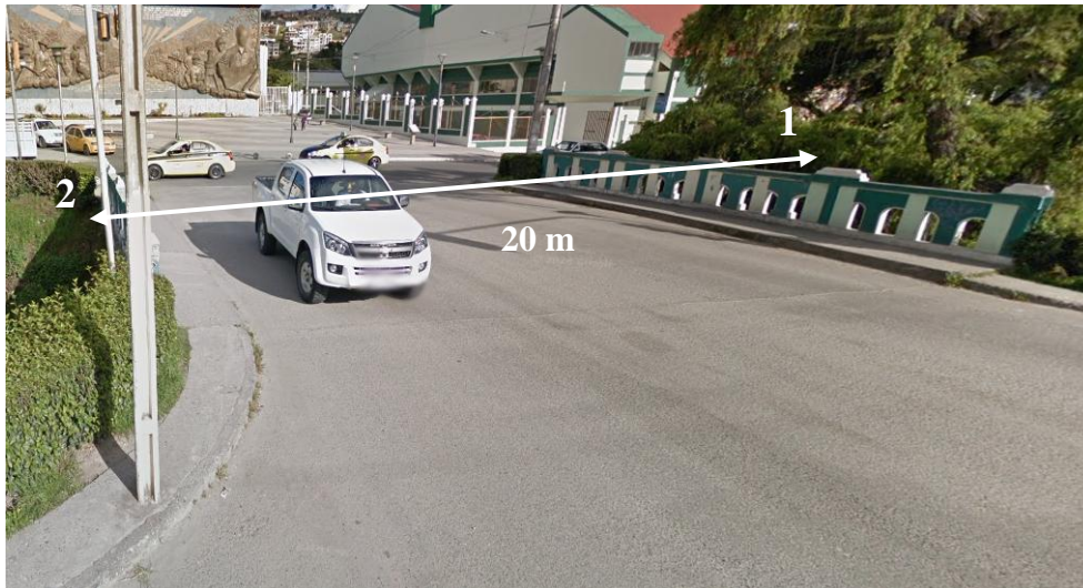
Figura 66. Longitud del puente de extremo a extremo
