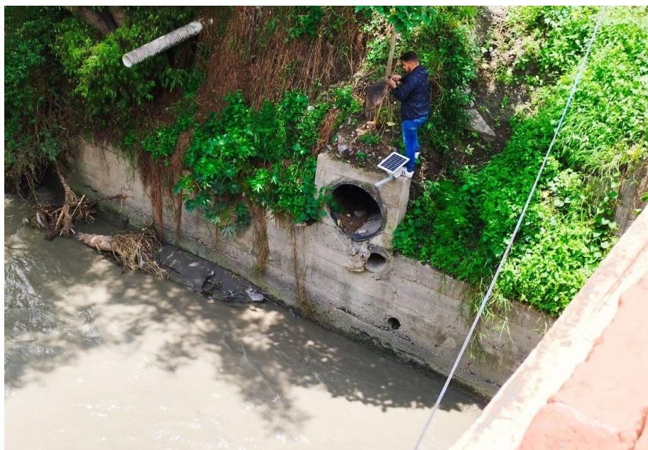
Figura 77. Toma de datos de caudal real
