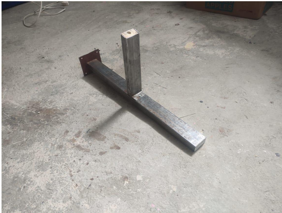
Figura 78. Construcción de estructura
