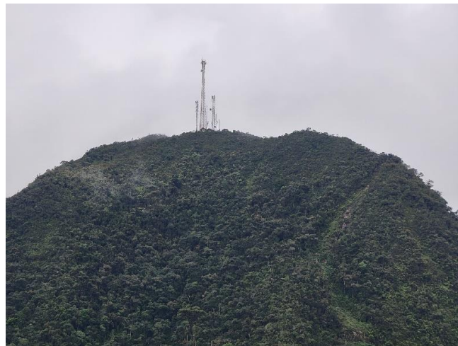
Figura 16. Punto de conexión en el cerro Chivato.
