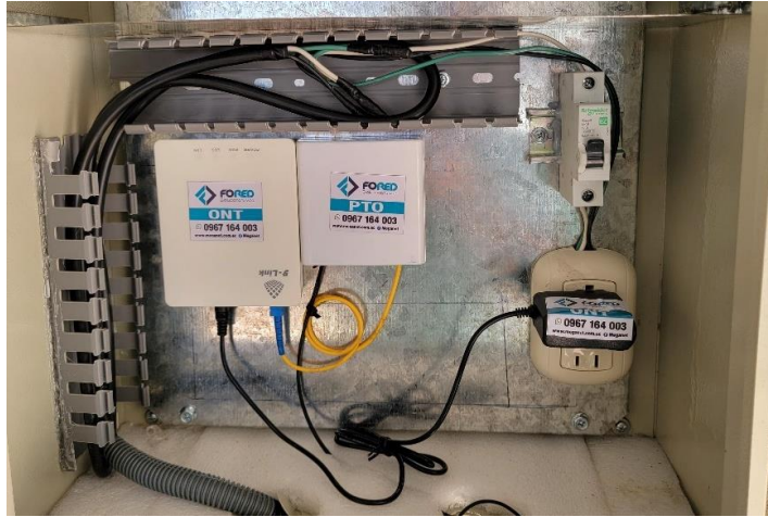
Figura 25. Instalación de la acometida de fibra óptica.
