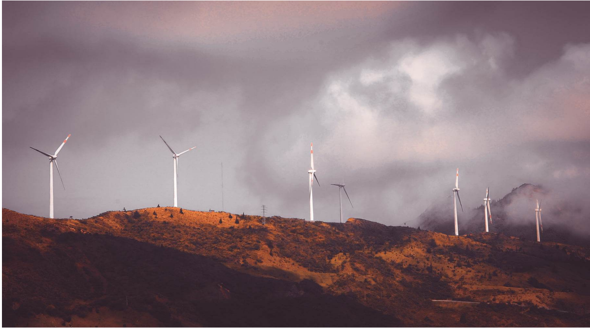
Figura 1. Central Eólica Villonaco.
