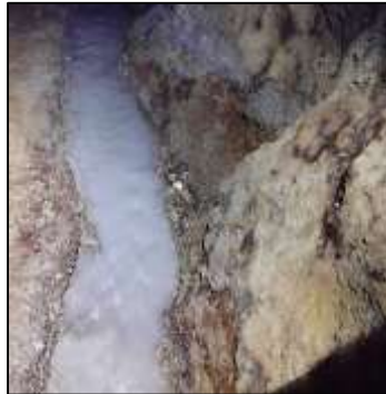
Figura 45. Cunetas de drenaje en la Socavón Principal
