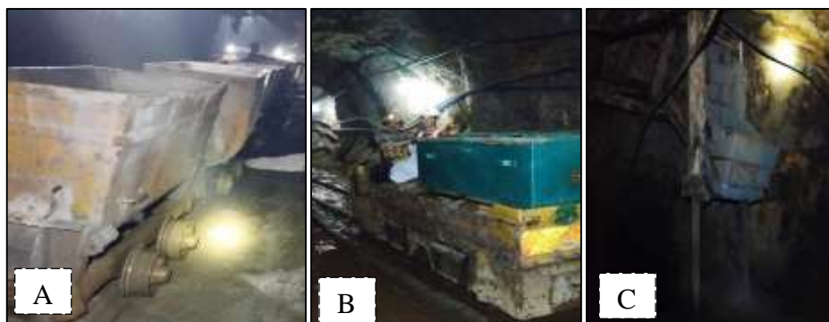
Figura 44. Carga y transporte de Material
