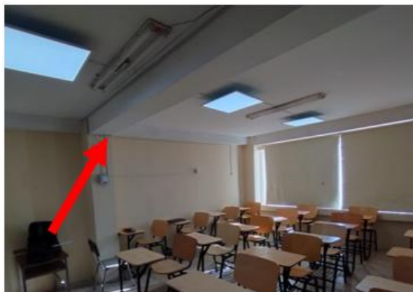
Figura 34. Viga que atraviesa el Aula A312
