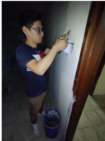
Figura 47. Instalación de medidor inteligente.
