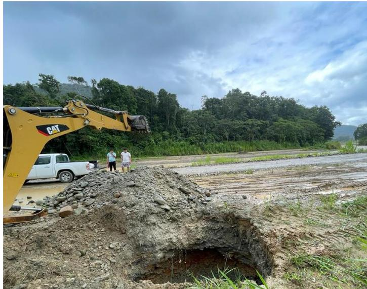
**Figura 14.** *Extracción de material fresco de las calicatas.* Elaborado por Torres (2022)
