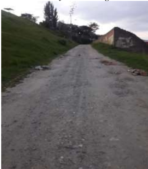
Calle sin asfaltado
