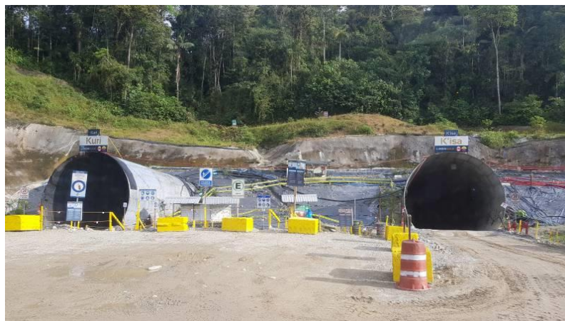
Bocas de túnel del campamento de la mina Fruta del Norte
