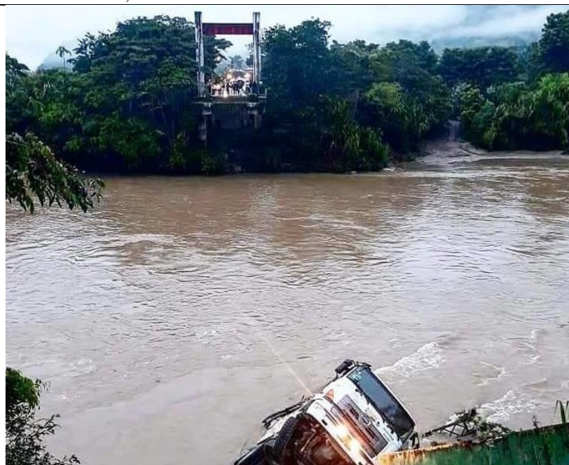
Puente caído sobre el río Zamora, parroquia Los Encuentros.
