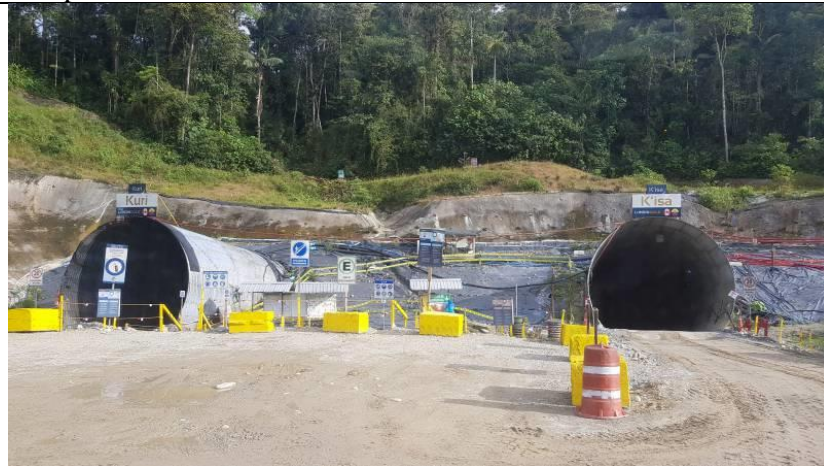
Bocas de túnel, Frute del Norte
