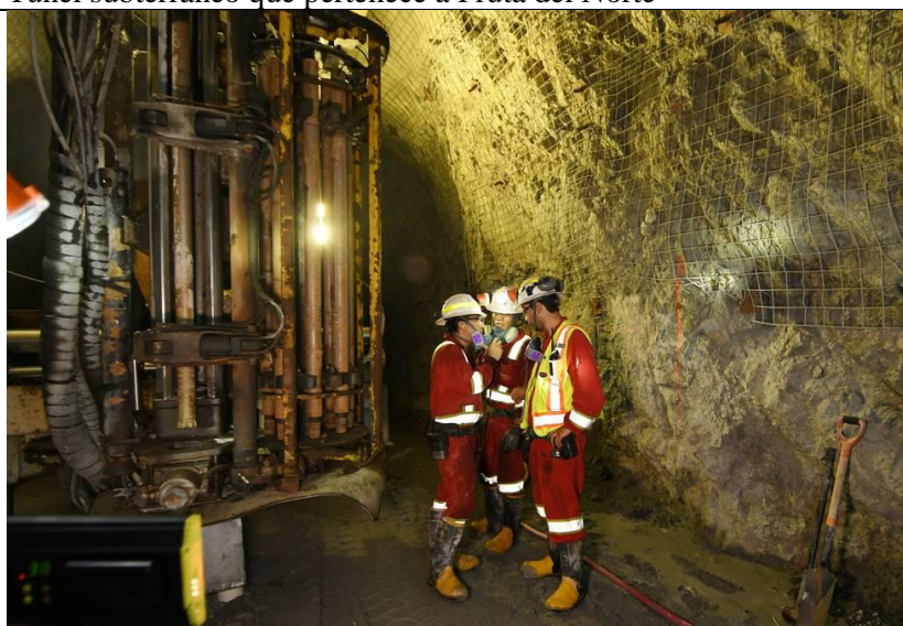
Túnel subterráneo que pertenece a Fruta del Norte
