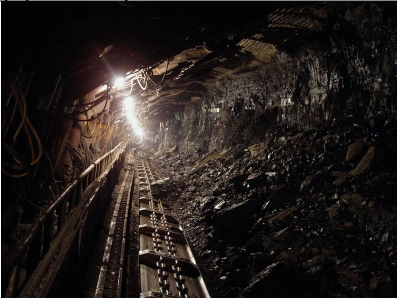
Túnel subterráneo, no se menciona a qué mina pertenece.
