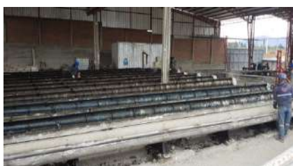
Figura 34 Fabricación de postes y sus derivados
