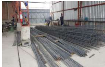
Área de varilla para figurado y armado de estructuras metálicas. La empresa cuenta con 2 soldadoras eléctricas y 1 roladora de anillos.
