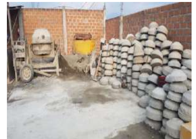
Área de almacenamiento de bloques de anclaje y cajas de revisión.
