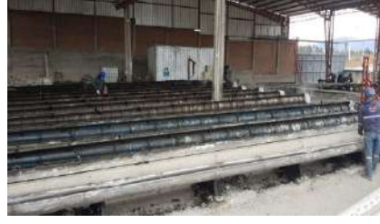
Área de moldes para la producción de postes de hormigón. La empresa cuenta con 14 moldes instalados y 59 vibradores eléctricos.
