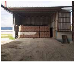
Área de almacenamiento de cemento. El área tiene una capacidad de almacenamiento de 600 sacos de cemento.
