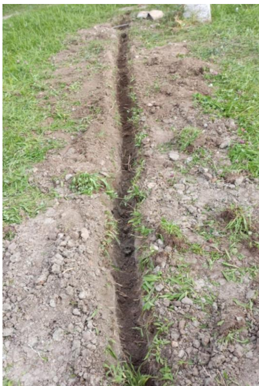
Figura 56. Excavación para soterramiento de manguera
