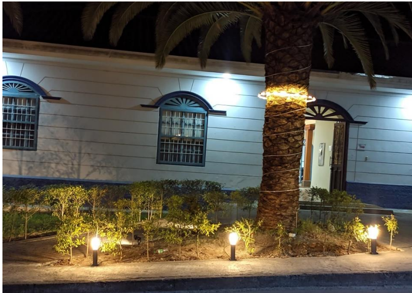
Figura 72. Luminarias de piso tipo poste encendidas
