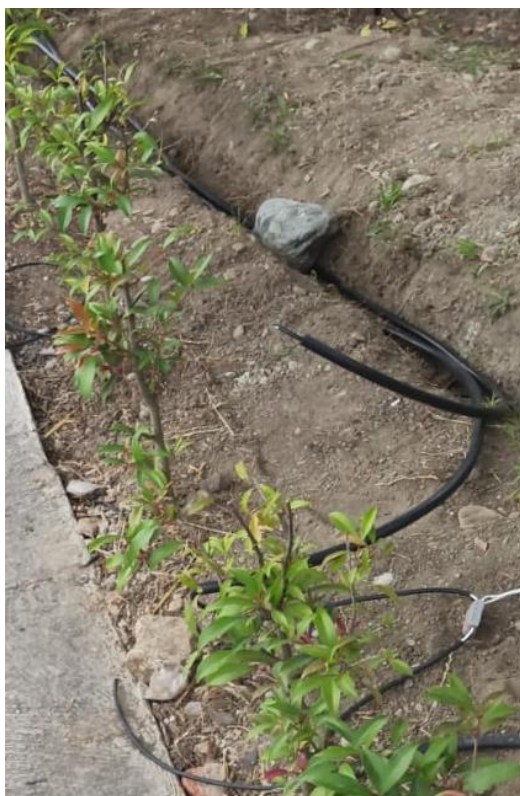
Figura 57. Soterramiento de manguera con tendido del conductor
