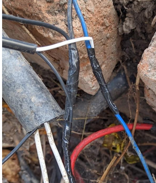
Figura 58. Derivación en paralelo
