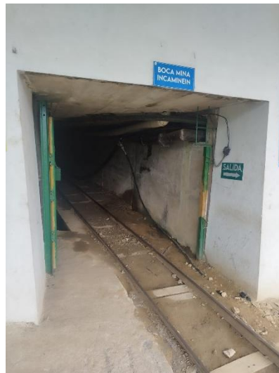
Figura 26. Boca mina del proyecto minero piedras verdes
