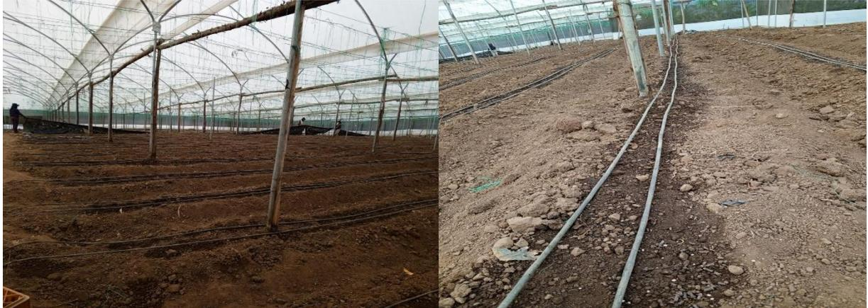
**Figura 19.** Preparación del suelo y estirado de los laterales de goteo en el invernadero.
