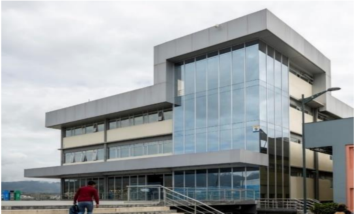
Figura 20. Vistas de la edificación.
