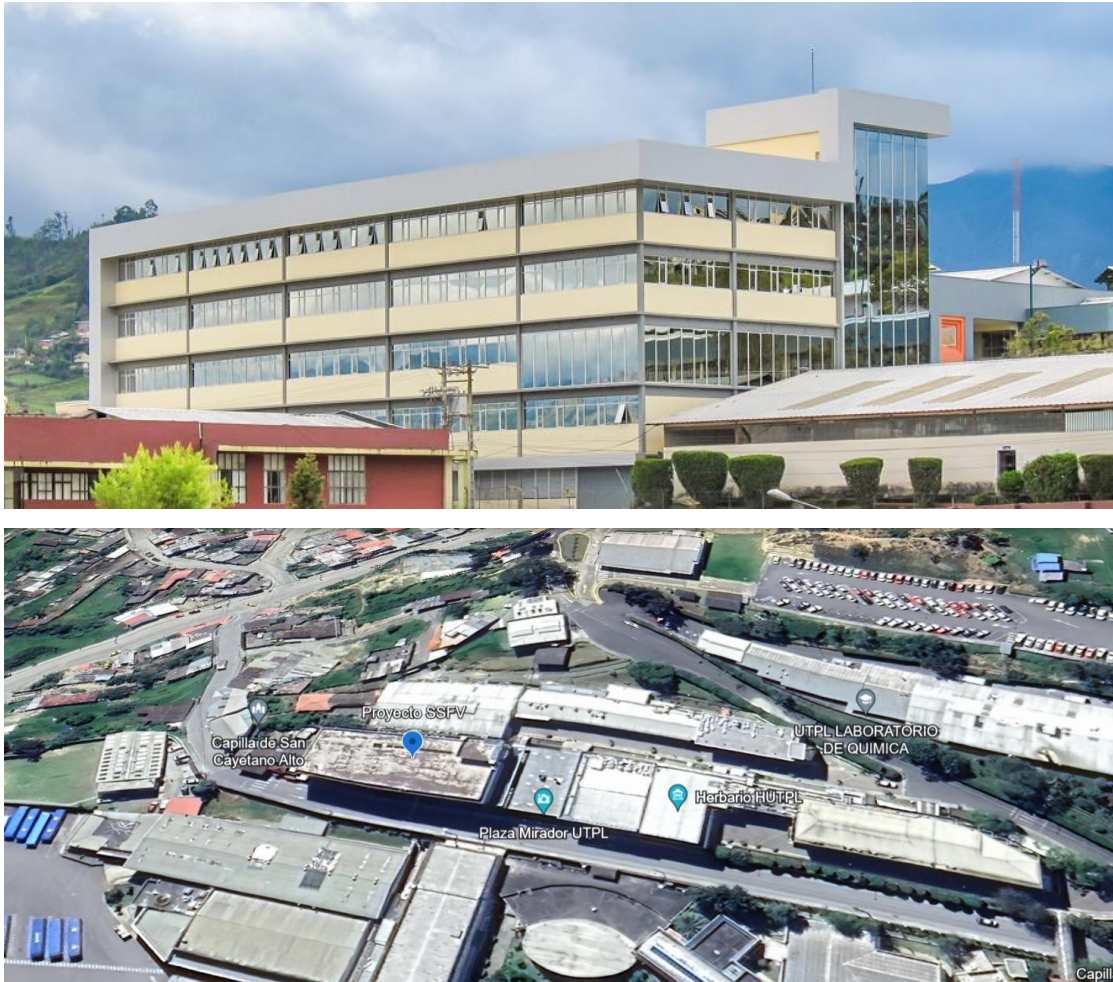
Figura 22. Instalación de módulos solares en el lugar asignado.
