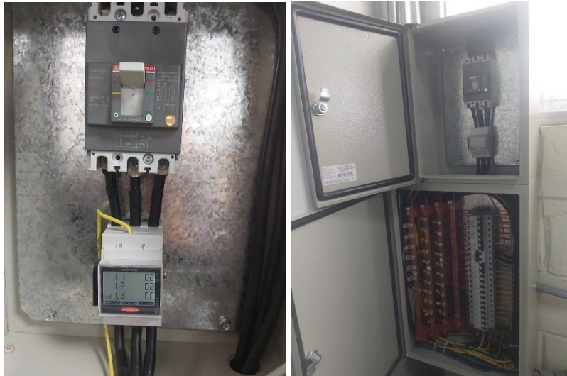
Figura 12. Instalación de contador bidireccional.
