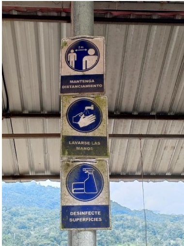
Figura 26. Señalética en mal estado
