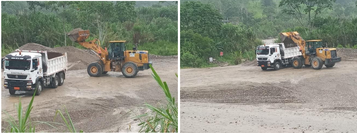
Figura 36 Transporte de material
