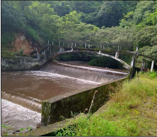
Figura 8. Captación sobre el Río Chiriyacu
