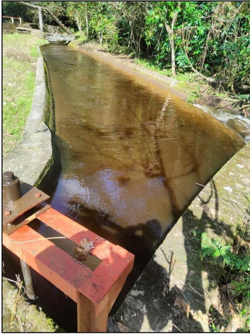
Figura 14. Desarenador del Sistema de Riego El Ingenio
