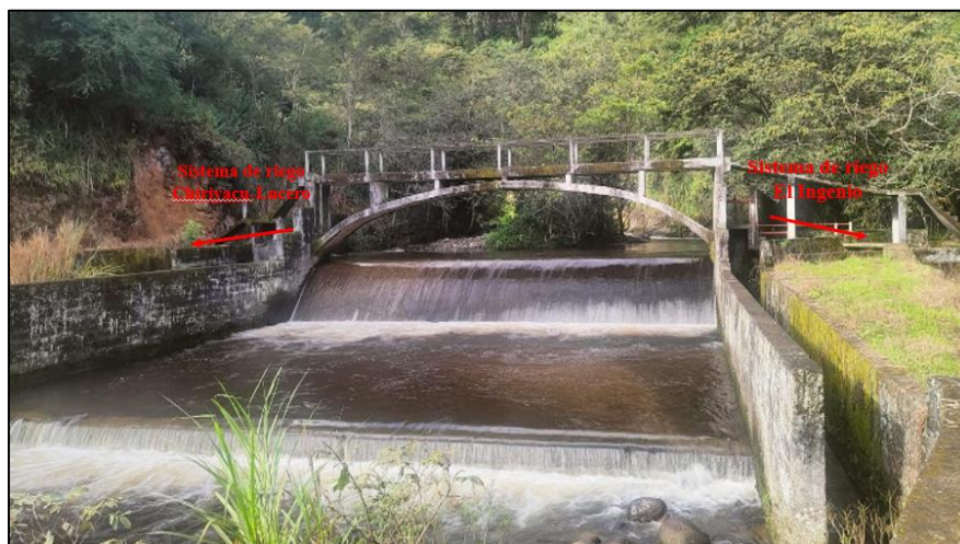
Figura 13. Obra de captación
