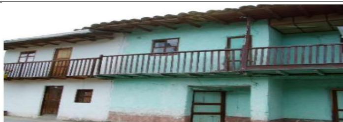
Figura 9. Casas de Interés Patrimonial
