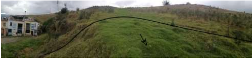
Figura 55. Deslizamiento Rotacional IV. Nota. Ruiz Escovar (2023)
