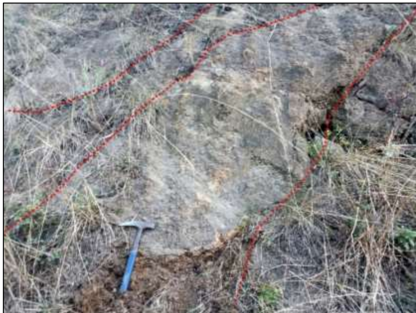
Figura 39. Agrietamiento de afloramiento. Nota. Ruiz Escovar (2023)
