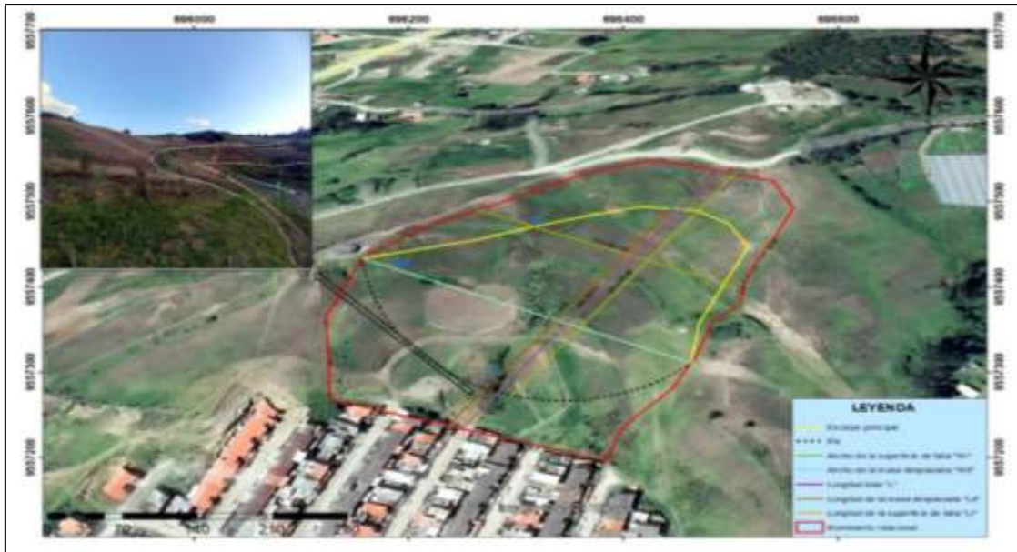
Figura 51. Deslizamiento en el área de estudio. Nota. Ruiz Escovar (2023)
