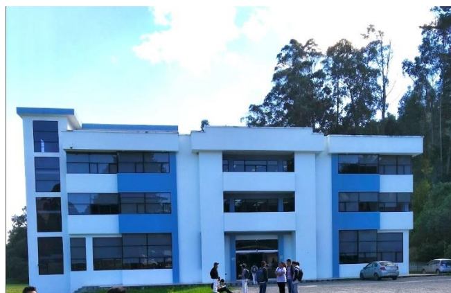
Figura 12. Edificio Bloque A2
