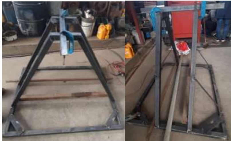
Figura 65. Proceso de construcción de la base.
