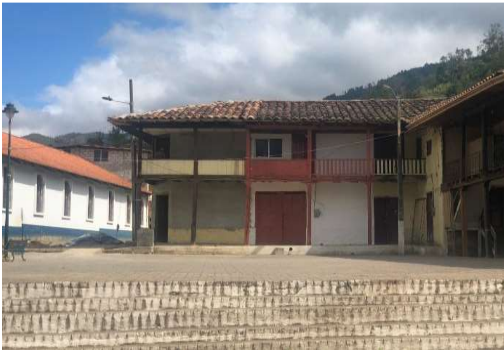
Nota. La imagen muestra casa deshabitada en el parque central de Chantaco.
