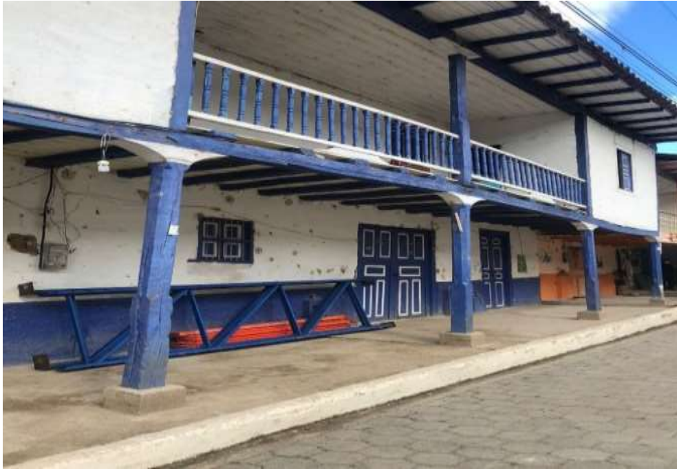
Nota. La imagen muestra casa deshabitada en el sector 2 al costado del parque central.
