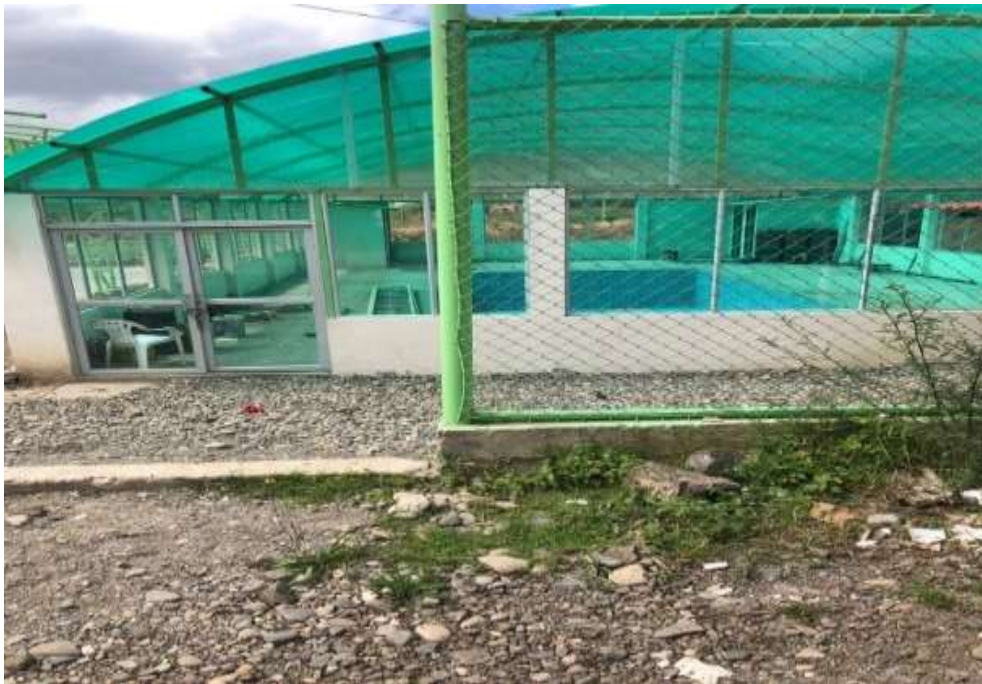
Nota. Durante el reconocimiento del barrio Chantaco se evidencia una piscina en construcción.
